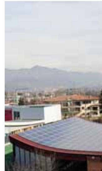
Barzana, uno dei pannelli installati
