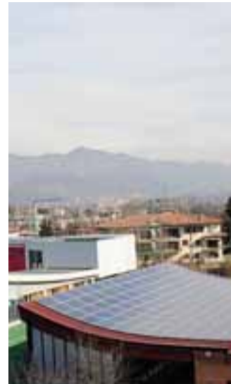
Barzana, uno dei pannelli installati
