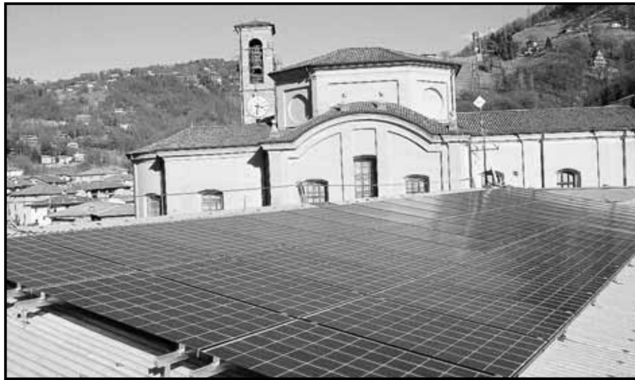
I pannelli solari posati sul tetto dell'oratorio
